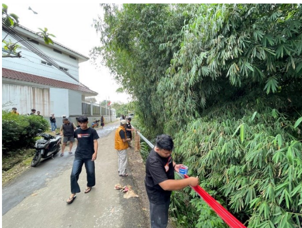
Gambar 1.4 pengecatan pagar pembatas antara jalan dan lereng
