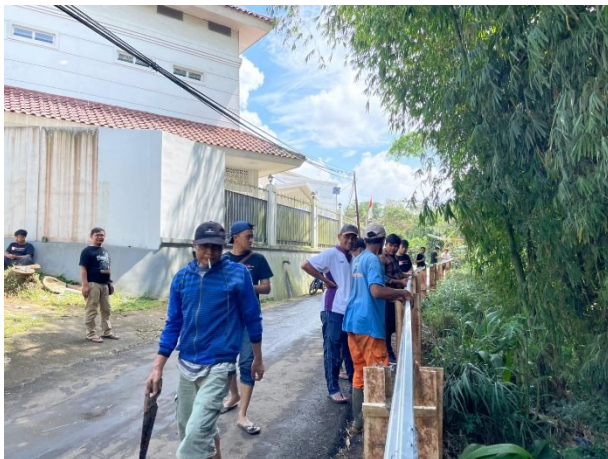
Gambar 1.3 progres pembuatan pagar pembatas antara jalan dan lereng bersama warga sekitar
